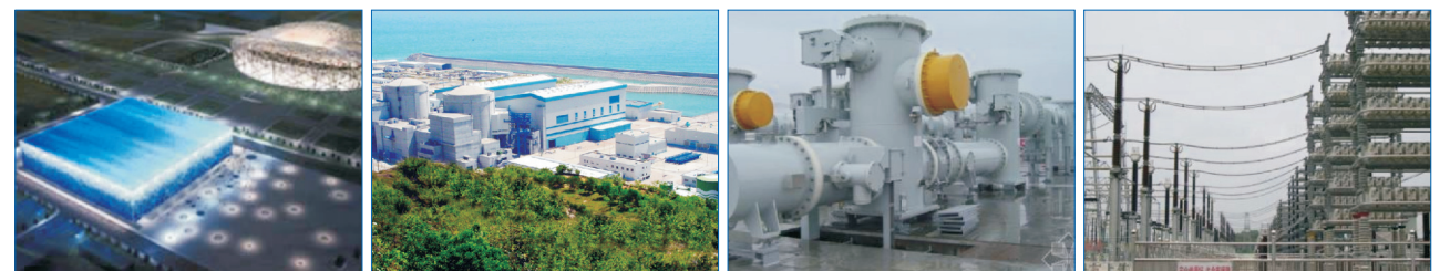
北京奥运保电工程
