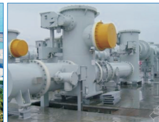
500KV变电站工程
