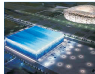
北京奥运保电工程
