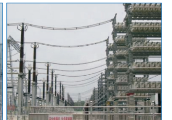
750KV变电站工程
